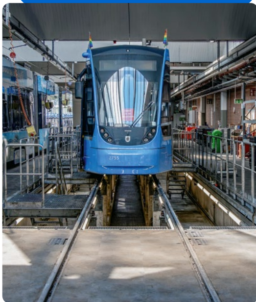
Arbeitsplatz mit Spezialperspektive: Blick in die Werkstatthalle des Straßenbahn-Betriebshofs Einsteinstraße, wo ein Avenio bereit zur Inspektion über der Grube steht.
