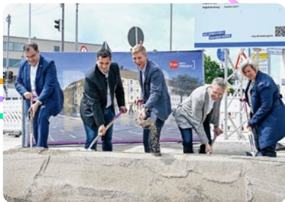
Spatenstich für die Tram-Westtangente 2024.
