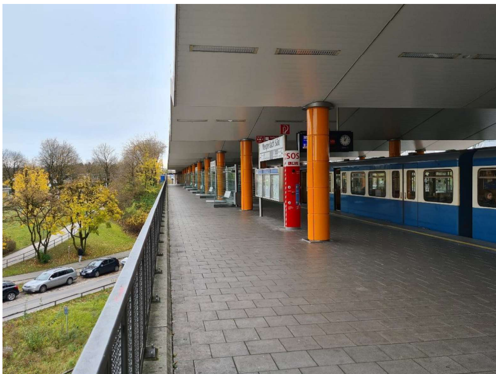
Abbildung 5: Bahnsteigbereich Bahnhof Neuperlach Süd, nordwestlicher Bahnsteigrand für Ergänzung 2. Gleis S-Bahn vorgesehen)
