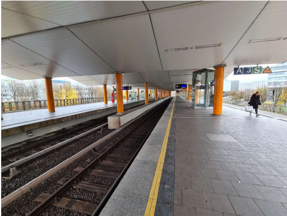
Abbildung 2: Bahnsteigbereich Bahnhof Neuperlach Süd (rechts DB-Gleis)
