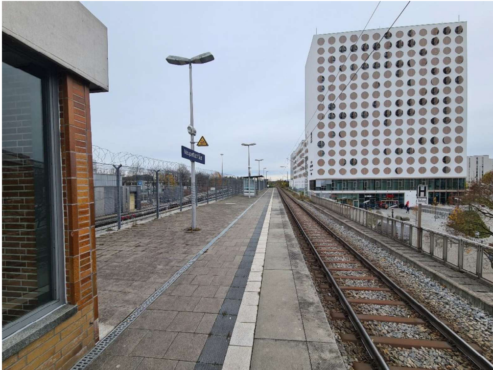
Abbildung 4: Bahnsteigbereich Bahnhof Neuperlach Süd, Bahnsteigverlängerung für S-Bahn
