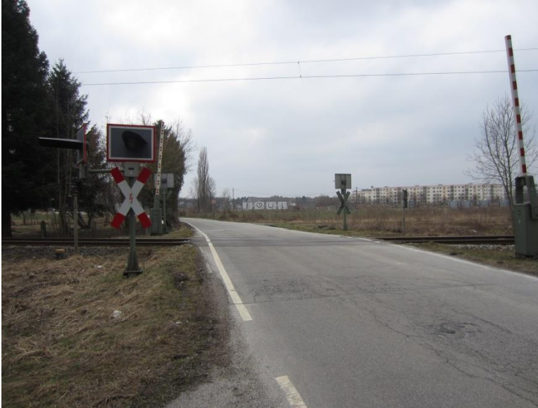
Abbildung 4: BÜ Arnold-Sommerfeld-Straße – Blickrichtung Westen
