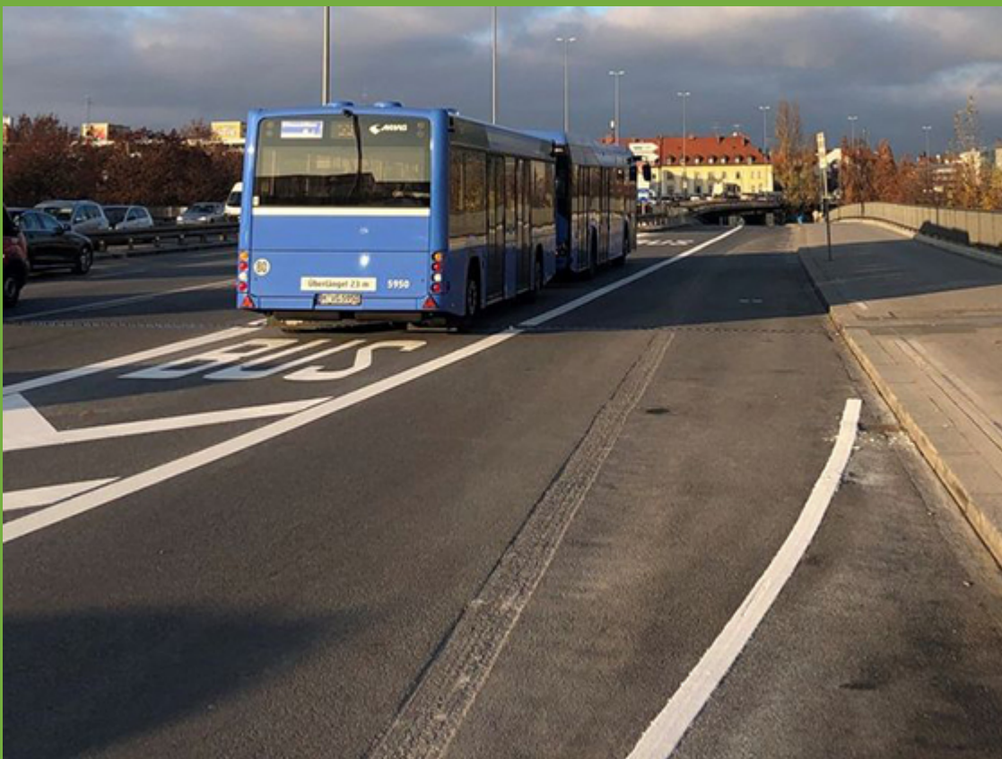
Busspur Donnersbergerbrücke, Rampe hinab zur Arnulfstraße
