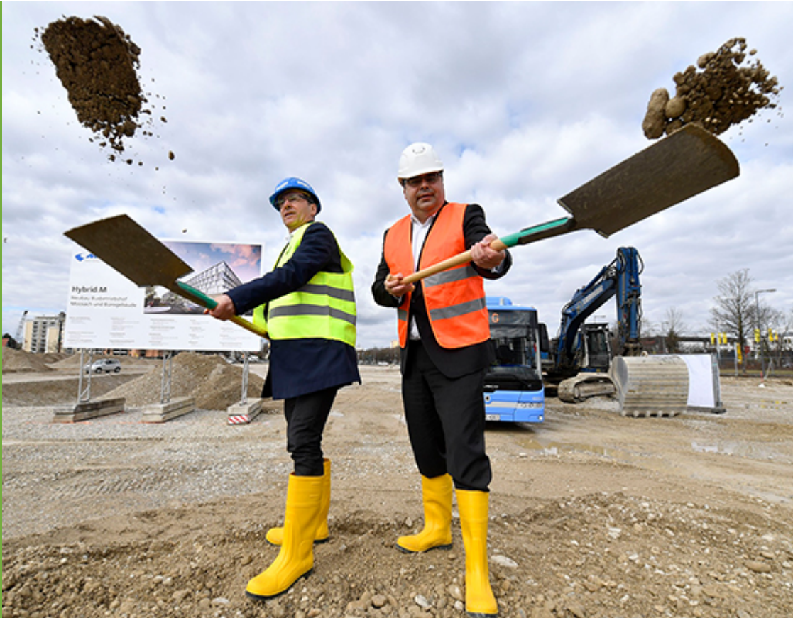
Neuer Busbetriebshof und Bürogebäude: Spatenstich für Hybrid.M - Werner Albrecht (links) und Ingo Wortmann. Foto © SWM
