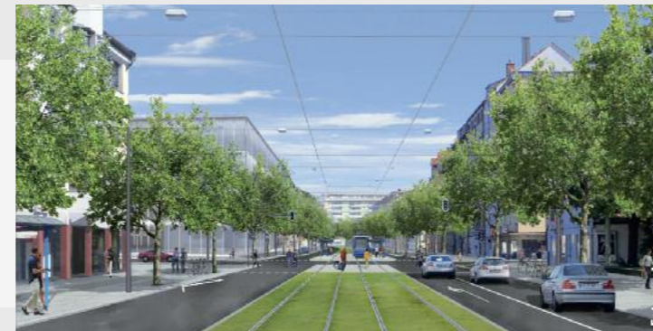
Nach der Neugestaltung wird es grün: die Landsberger Straße mit Rasengleis und Baumallee.
